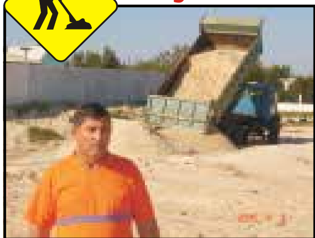
Nequinho está fazendo a canalização junto a EMEI Tio Moisés.
